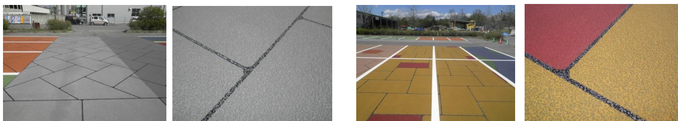
写真-1 ポーラス・ファインⅡの色調と仕上がり例 (当社駐車場)
