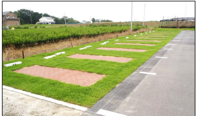
竣工直後の状況
