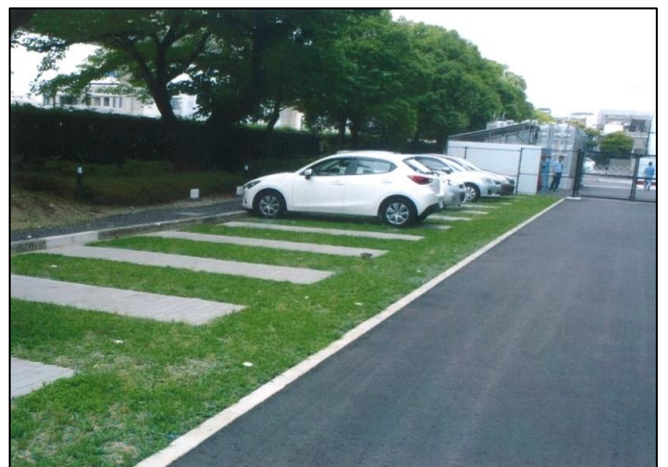
新規施工事例（芝種 セントオーガスチン） 2017年6月竣工
