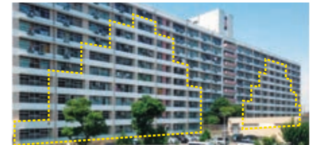
セスレット工法 ※黄色点線で囲まれた部分が補強箇所
