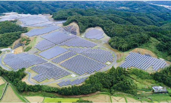
FBIT美咲発電所(岡山県)
