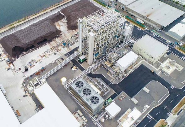
愛知蒲郡バイオマス発電所(愛知県)
