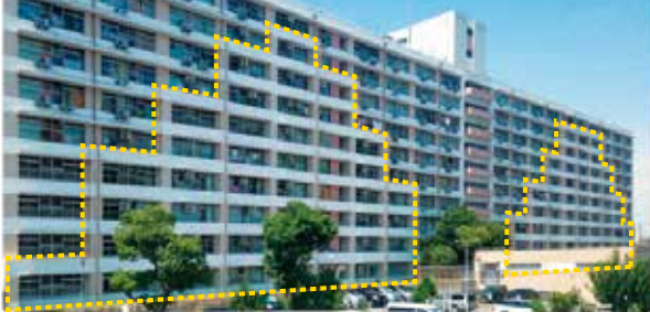
セスレット工法 ※黄色点線で囲まれた部分が補強箇所
