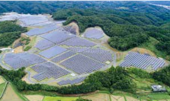
FBIT美咲発電所(岡山県)
