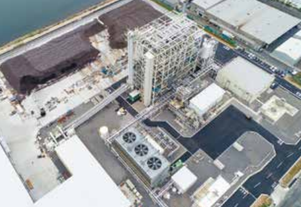
愛知蒲郡バイオマス発電所(愛知県)
