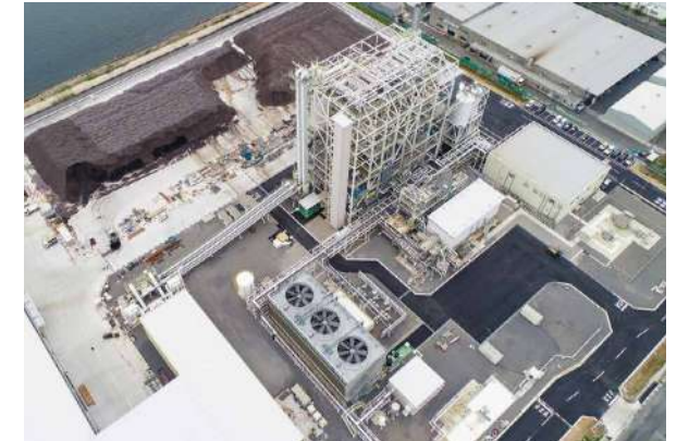
愛知蒲郡バイオマス発電所(愛知県)
