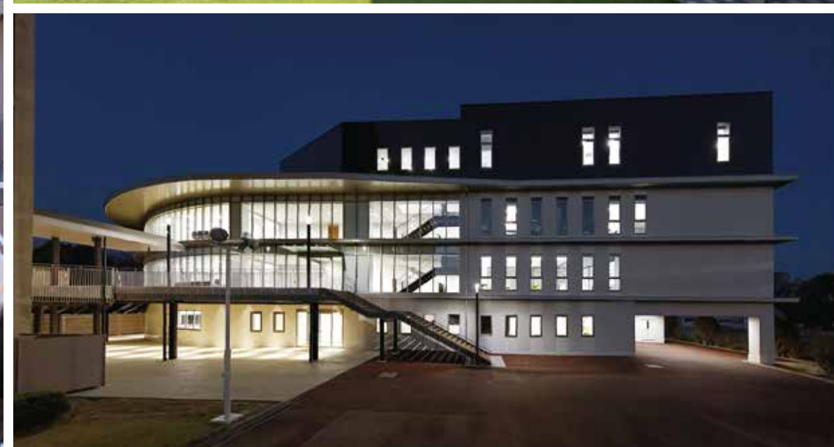
上/北側外観* 下/西側夜景
