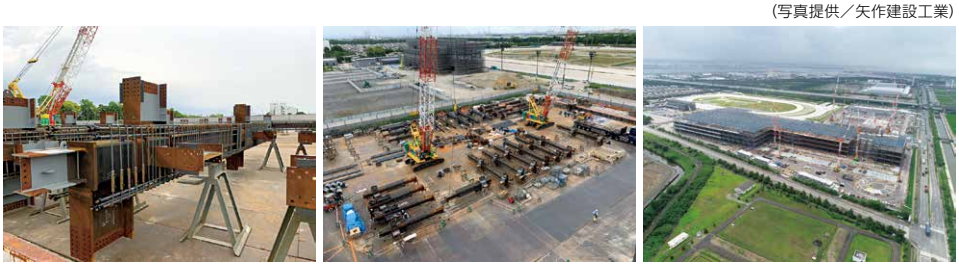
SRC柱の鉄筋地組
