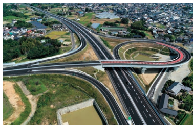
南知多道路 武豊北インターチェンジ新設工事
