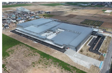
内浜化成豊田福受工場 愛知県豊田市
