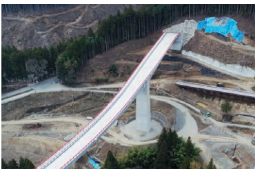
令和4年度 設楽ダム国道257号4号橋下部工事
