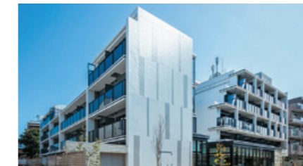
集合住宅(学生向け) 東京都板橋区
