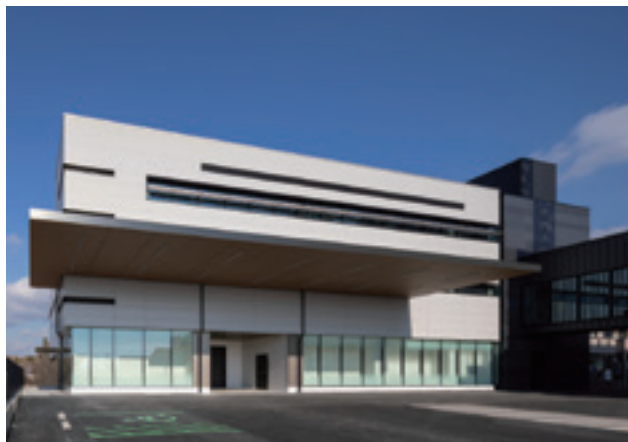
ひまわりネットワーク株式会社新館増築工事
