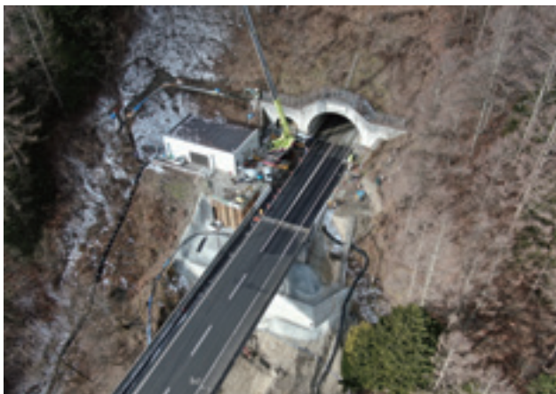
令和元年度 権兵衛峠道路災害復旧工事
