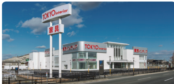
東京インテリア家具 瑞穂店新築 施工場所:岐阜県瑞穂市 発注者:株式会社 東京インテリア家具
