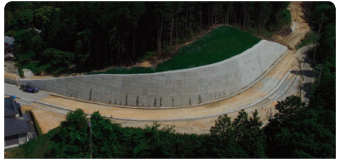
市道甲西駅美松線道路改良(パンウォール) 施工場所: 滋賀県湖南市 発注者: 株式会社 奥田工務店
