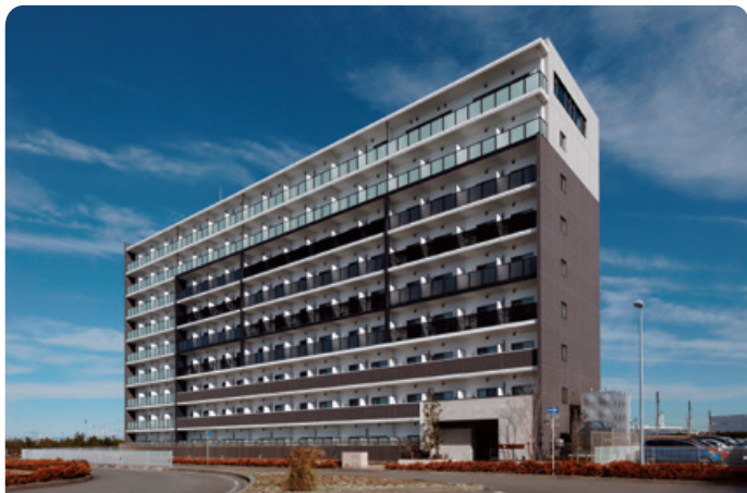
中部スカイサポート 社員寮新築 施工場所:愛知県常滑市 発注者:中部スカイサポート株式会社
