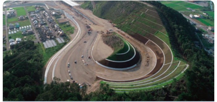
平成29年度 東海環状高富IC南部道路建設 施工場所: 岐阜県山県市 発注者: 国土交通省 中部地方整備局
