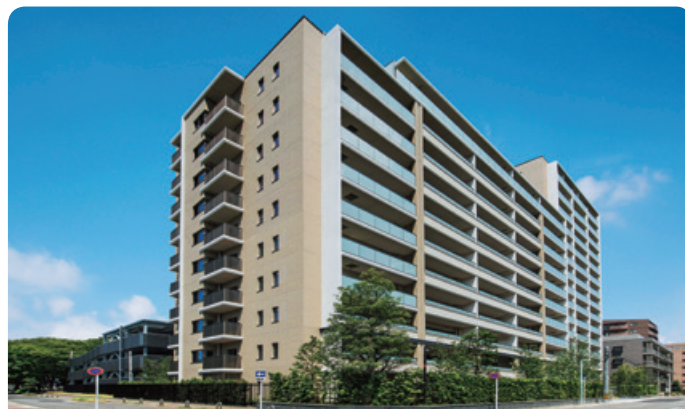
マストスクエア榎木町新築 施工場所:愛知県名古屋市東区 発注者:積水ハウス不動産中部株式会社
