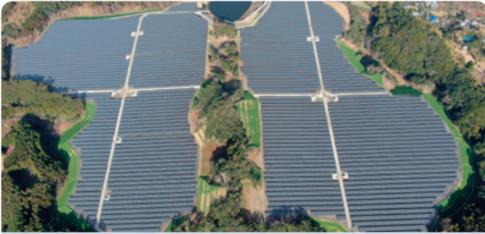
勝浦メガソーラー発電所建設 施工場所: 千葉県勝浦市 発注者: 東洋エンジニアリング株式会社
