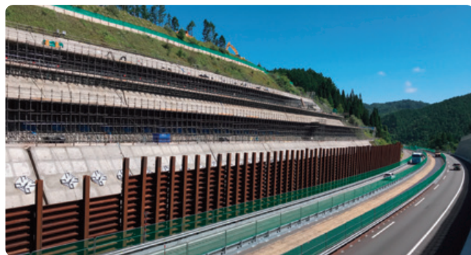
▲平成30年7月豪雨時の東海北陸自動車道の法面復旧工事状況②
