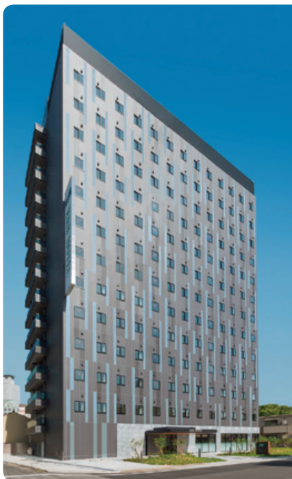
R & B ホテル則武二丁目計画 施工場所:愛知県名古屋市中村区 発注者:ワシントンホテル株式会社
