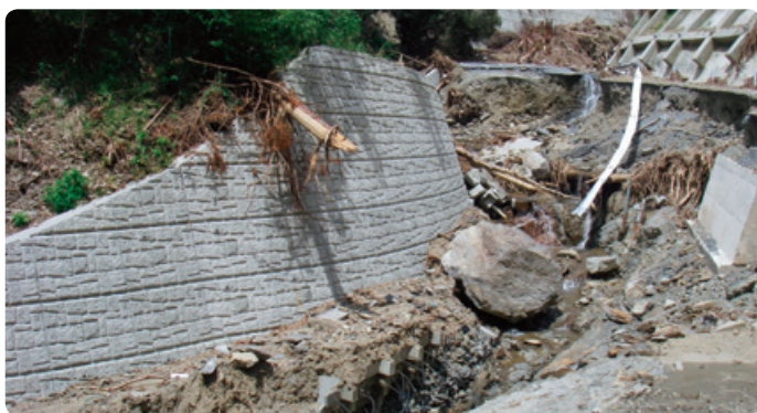
▲平成29年7月九州北部豪雨時のパンウォール工法の施工箇所
