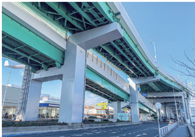
平成30年度高速1号楠線床版等修繕工事(五反田工区) 愛知県名古屋市
