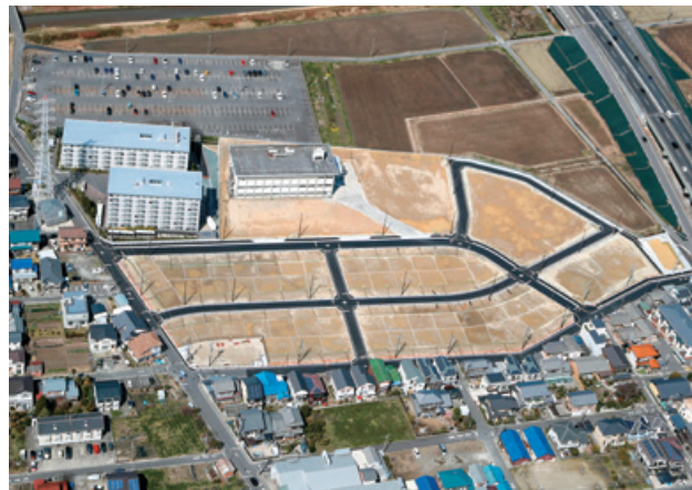
刈谷市今川町造成工事 愛知県刈谷市
