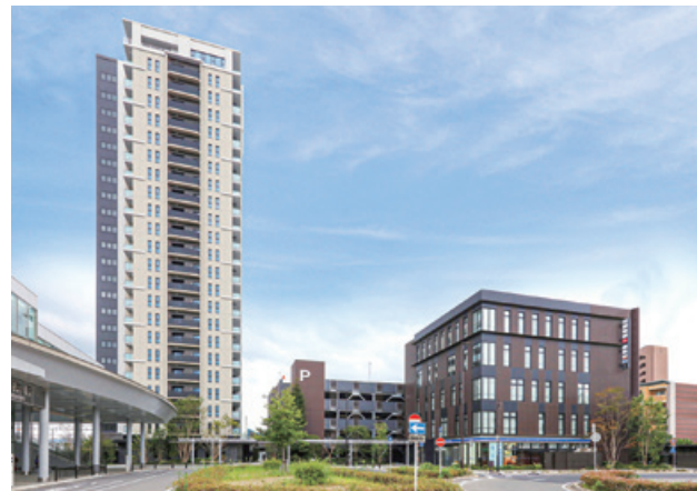
JR春日井駅南東地区第一種市街地再開発事業 愛知県春日井市
