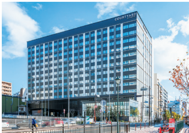
コートヤード・バイ・マリオット名古屋 愛知県名古屋市
