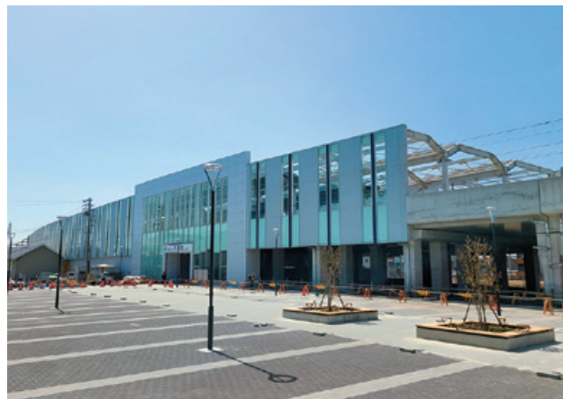
犬山線 布袋駅付近鉄道高架化事業に伴う本線土木工事 愛知県江南市
